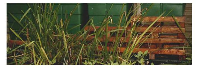
Dieses Foto hat uns ein Kunde geschickt. Er hat bei seinem Unterbau alles komplett richtig gemacht. Alle 4 Regentonnen stehen sicher auf der Balkenkonstruktion. Man kann alle 4 Auslaufhähne auf der Rückseite wunderbar erreichen. Zusätzlich kann man das Holz imprägnieren. Wenn man Lärchenholz verwendet ist am sinnvollsten die Balken nicht zu streichen. Da das Lärchenholz witterungsbeständig ist.
