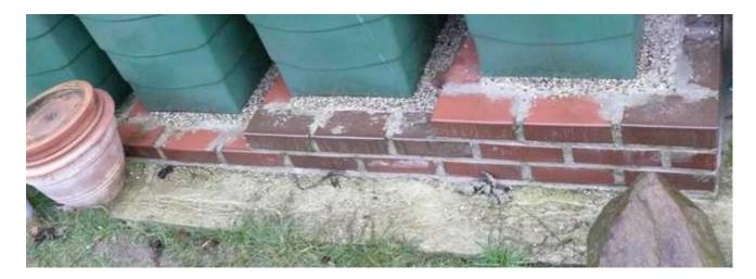
Der Unterbau für die *Stufen des Teichfilters* wurde hier aus Ziegel gemauert. Darunter befindet sich das Betonfundament. Wenn Sie den Unterbau herstellen ist es wichtig dass alles mit der Wasserwage ausgelotet wird. Nicht dass dann später die Tonnen schief
