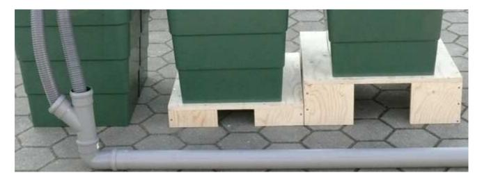
Wenn Sie **Auslaufhähne an den Regentonnen** installieren möchten ist es zweckmäßig die letzte Tonne ebenfalls auf ein Podest zu setzen, damit das <u>Auslaufhahnsystem</u> einigermaßen in der Luft hängt. Nicht direkt am Boden.
